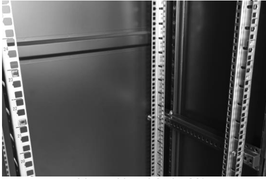
- zamontować koszyki pod śruby M6
